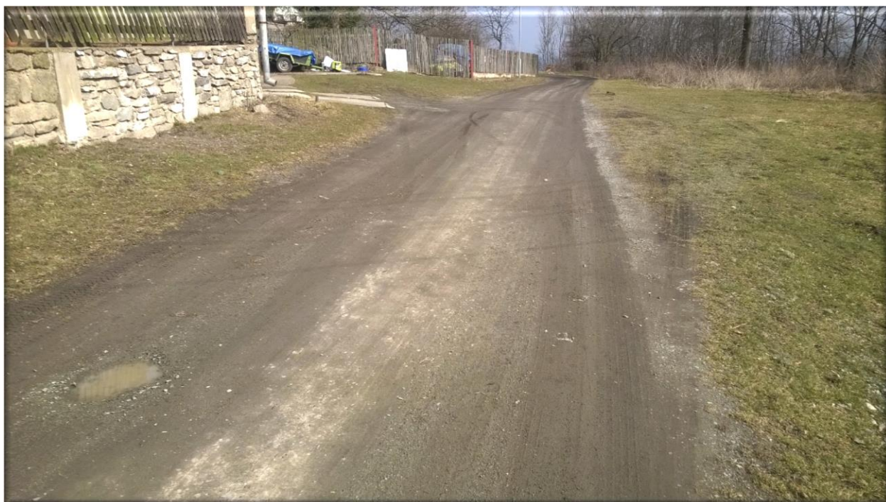
Obrázek 23: Místní komunikace - plánovaná rekonstrukce
