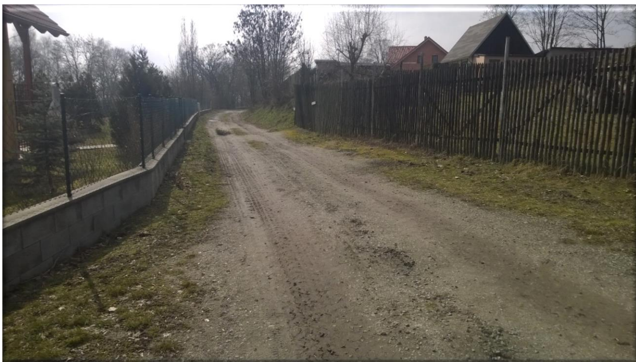
Obrázek 25: Cesta ke sběrnému dvoru - plánována rekonstrukce
