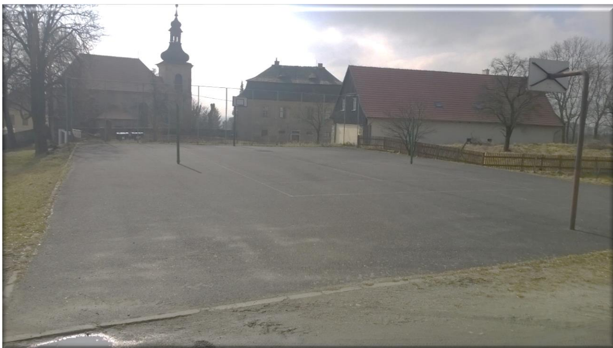
Obrázek 12: Víceúčelové asfaltové hřiště
