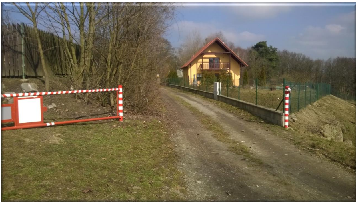
Obrázek 26: Cesta ke sběrnému dvoru - plánována rekonstrukce
