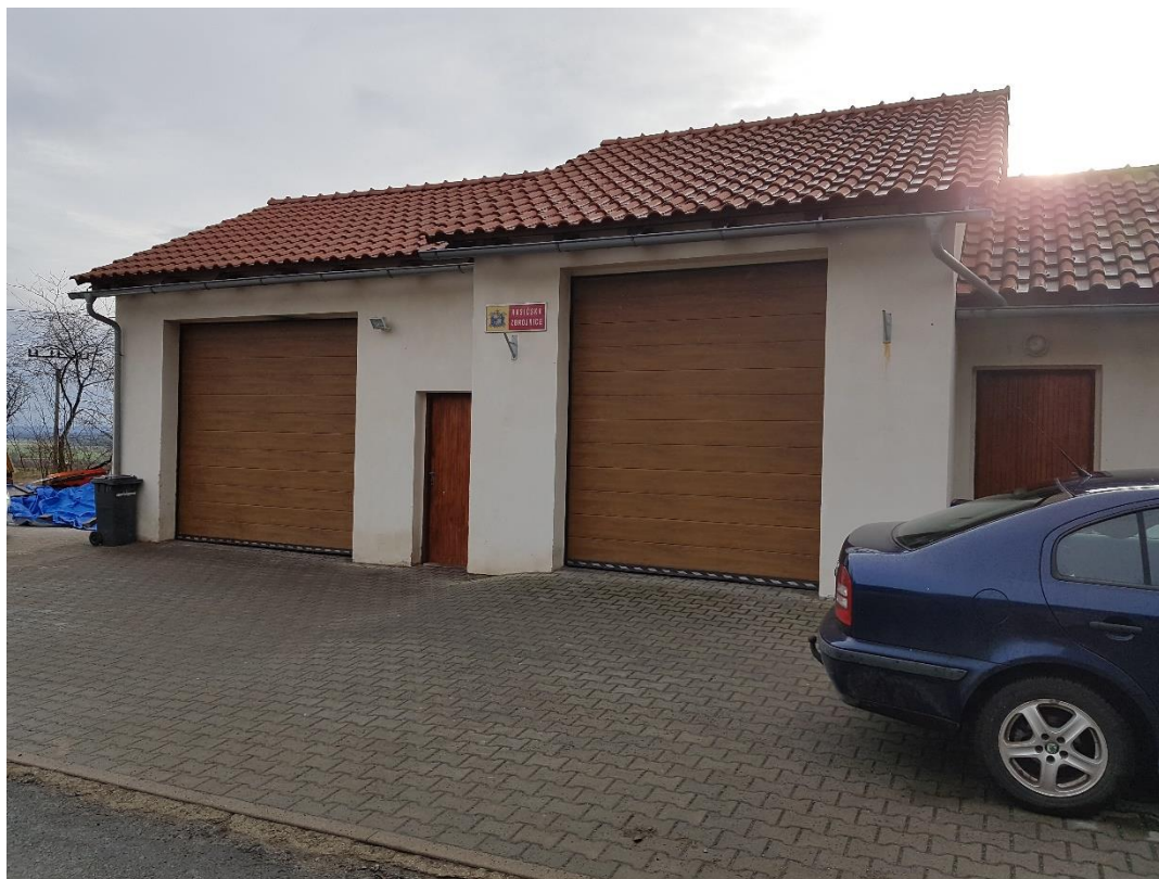
Obrázek 22: Hasičská zbrojnice Bezděz
